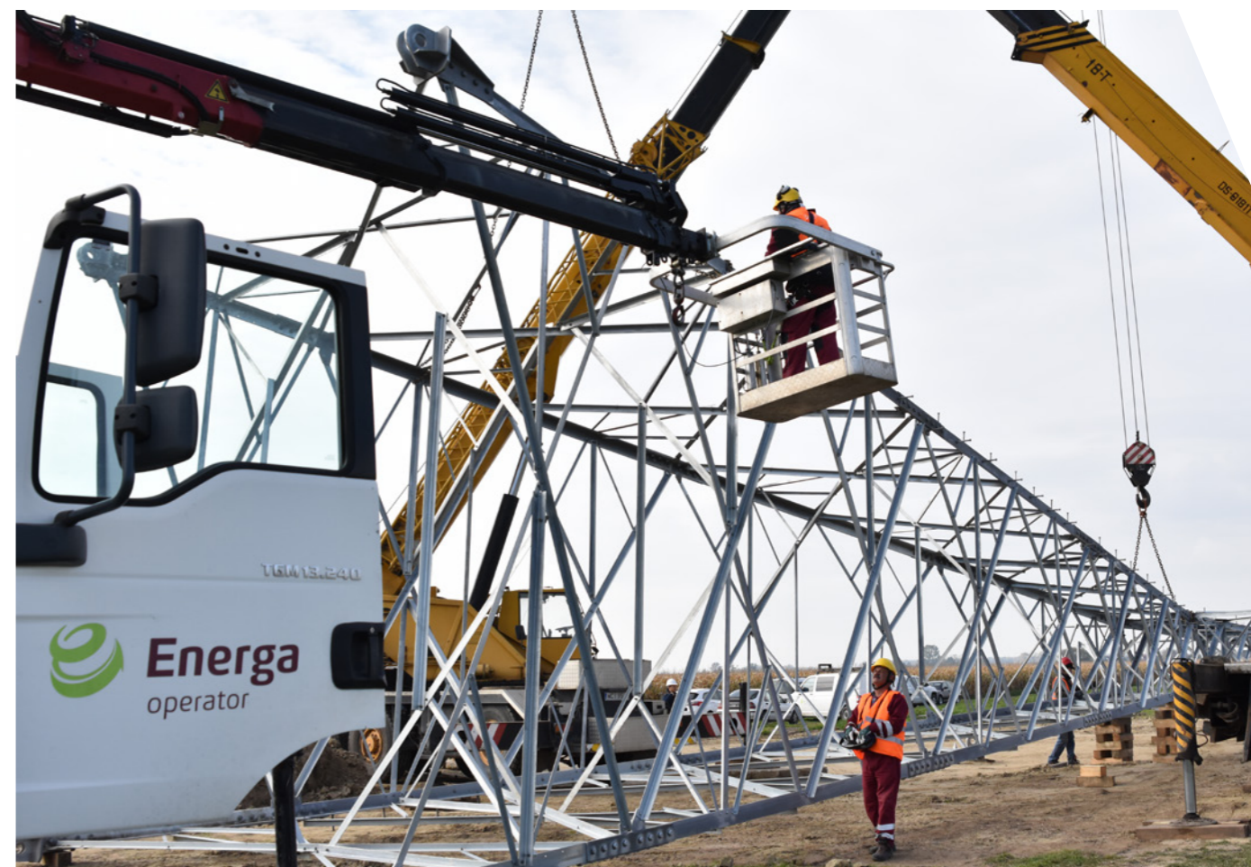
Energa-Operator, Budowa dwutorowej linii napowietrznej WN
