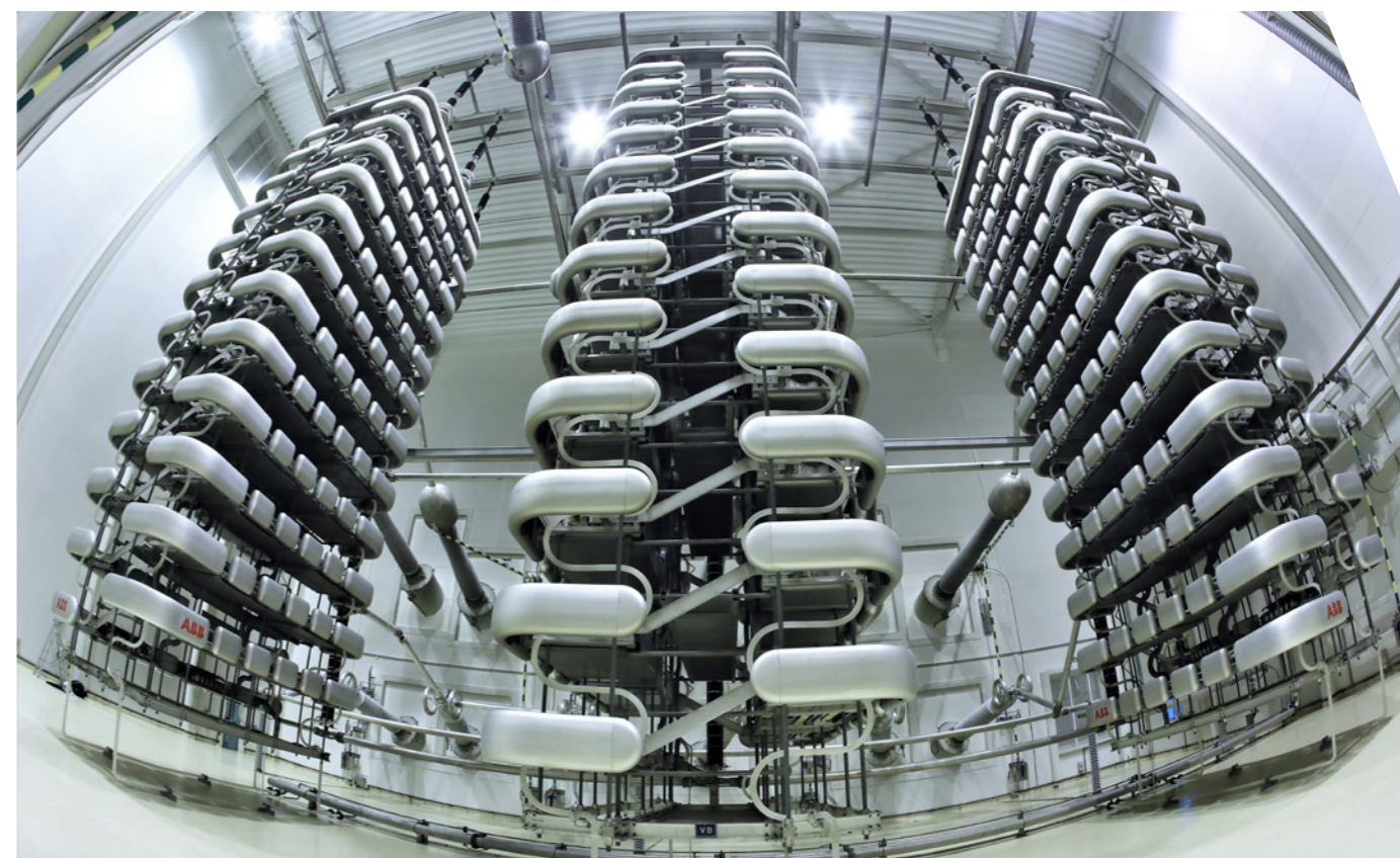
PSE, Fragment hali tyrystorowej w stacji przekształtnikowej w miejscowości Wierzbienin (połączenie DC Polska - Szwecja)
