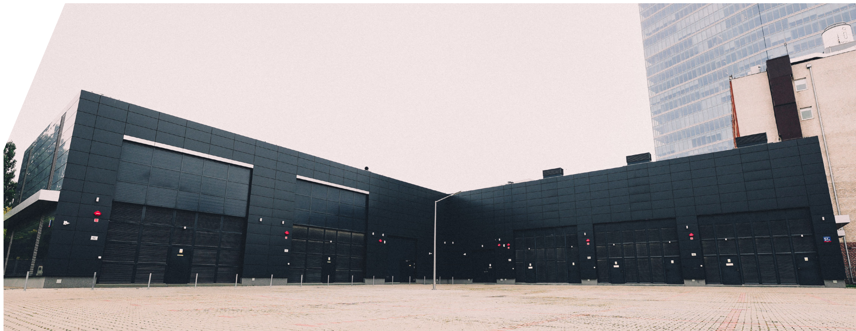
Stoen Operator, Budynek stacji elektroenergetycznej Towarowa
