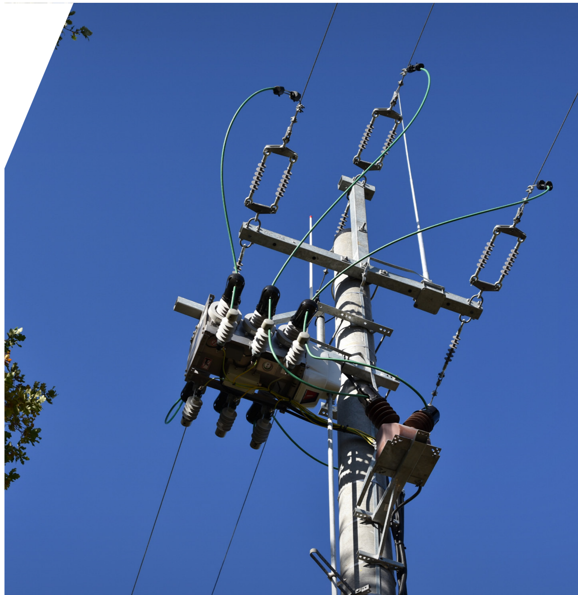
Energia-Operator, Łącznik zdalnie sterowany z monitorowaniem parametrów pracy sieci SN i wykrywaniem zwarc
