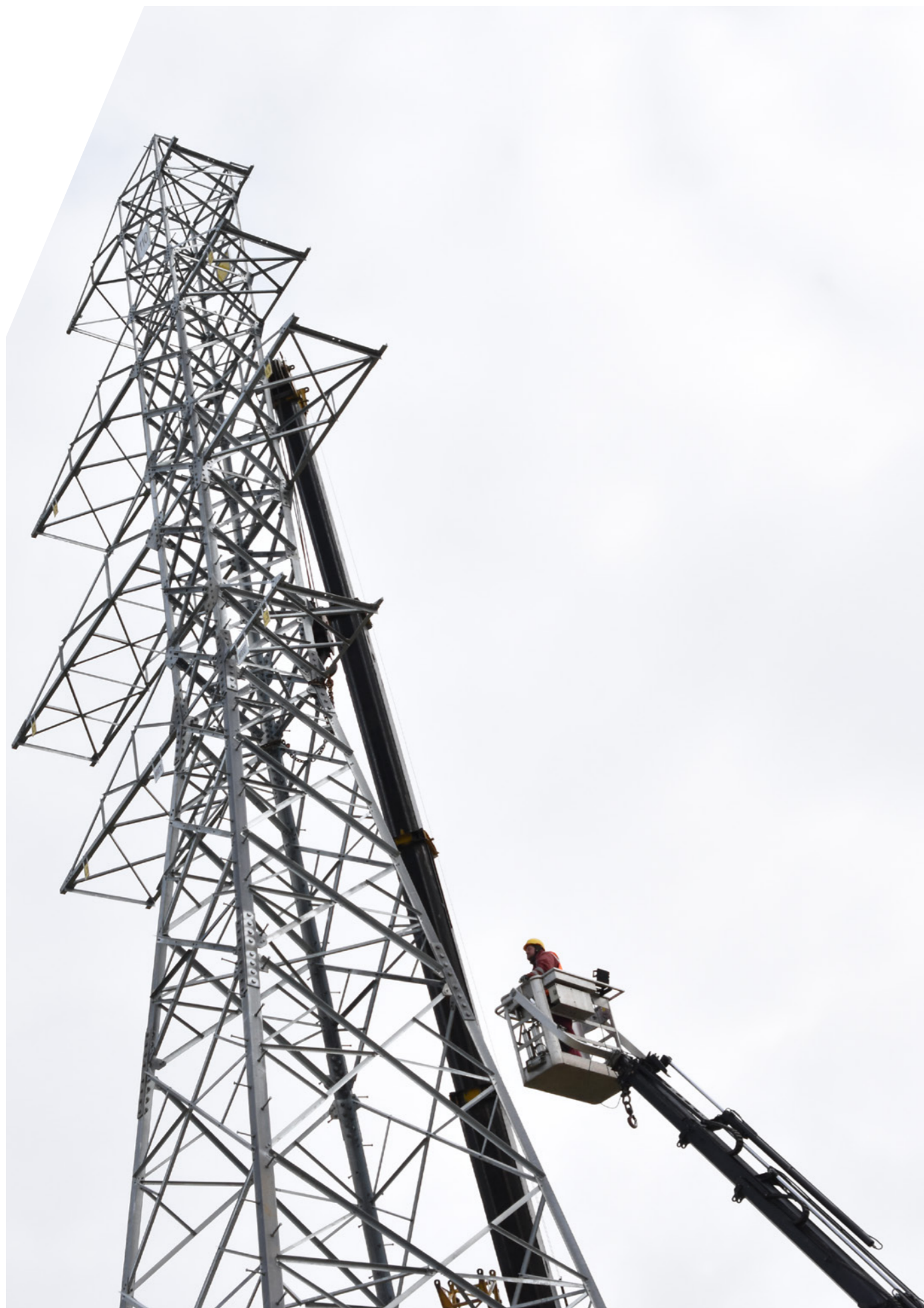
Energa-Operator, stawianie słupa dwutorowej linii napowietrznej WN
