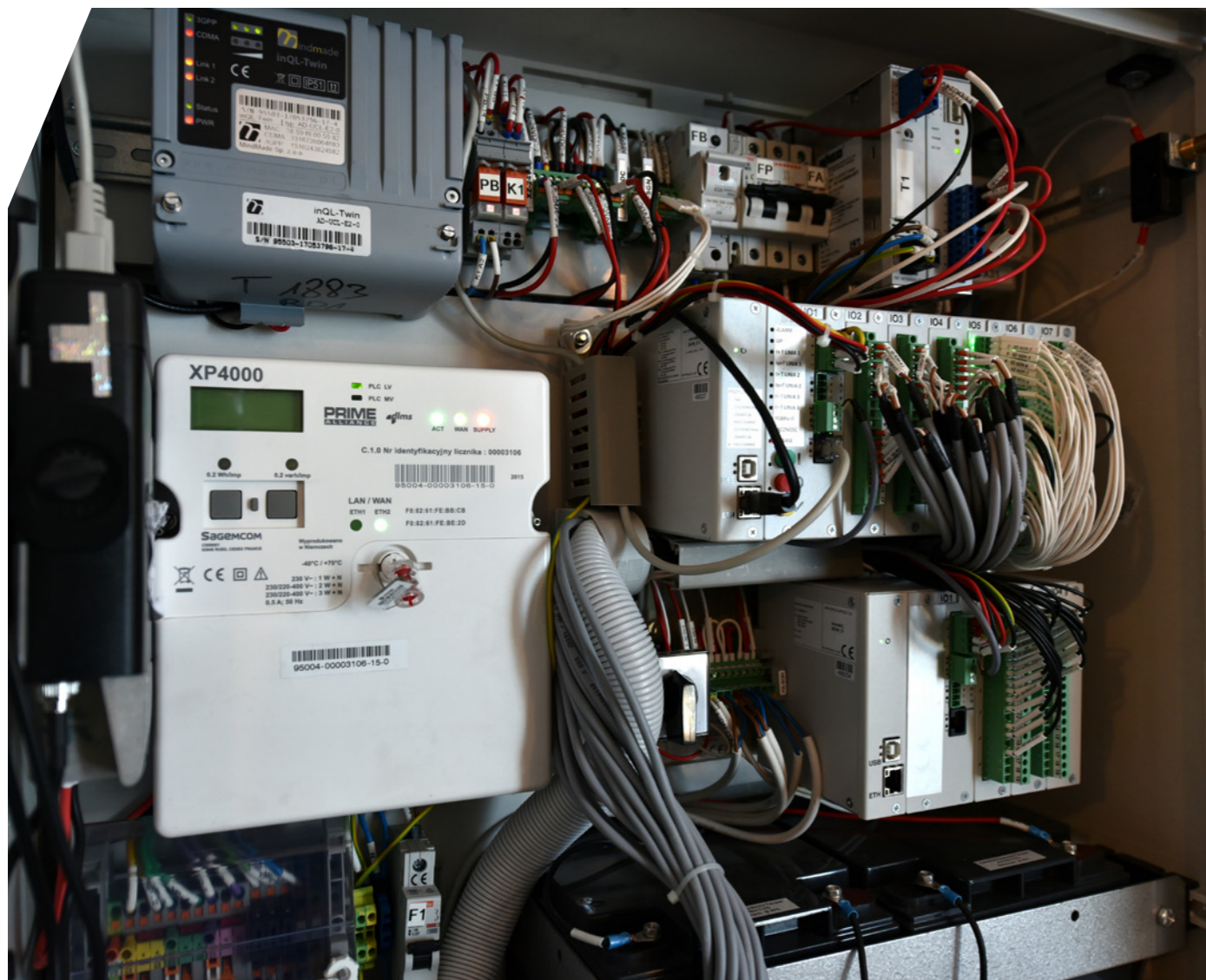
Energa-Operator, Szafka AMI/SG – zintegrowane rozwiązanie do sterowania i monitorowania w stacjach transformatorowych SN/nn
