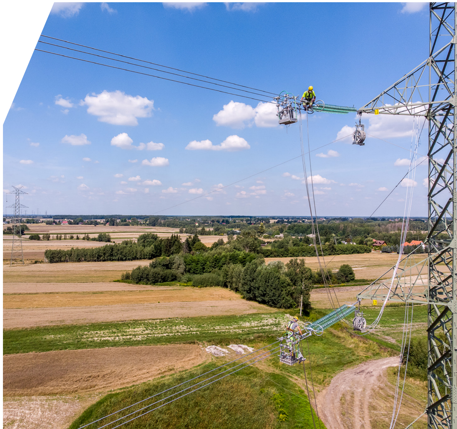
PSE, Budowa linii 400 kV Chełm - Lublin Systemowa
