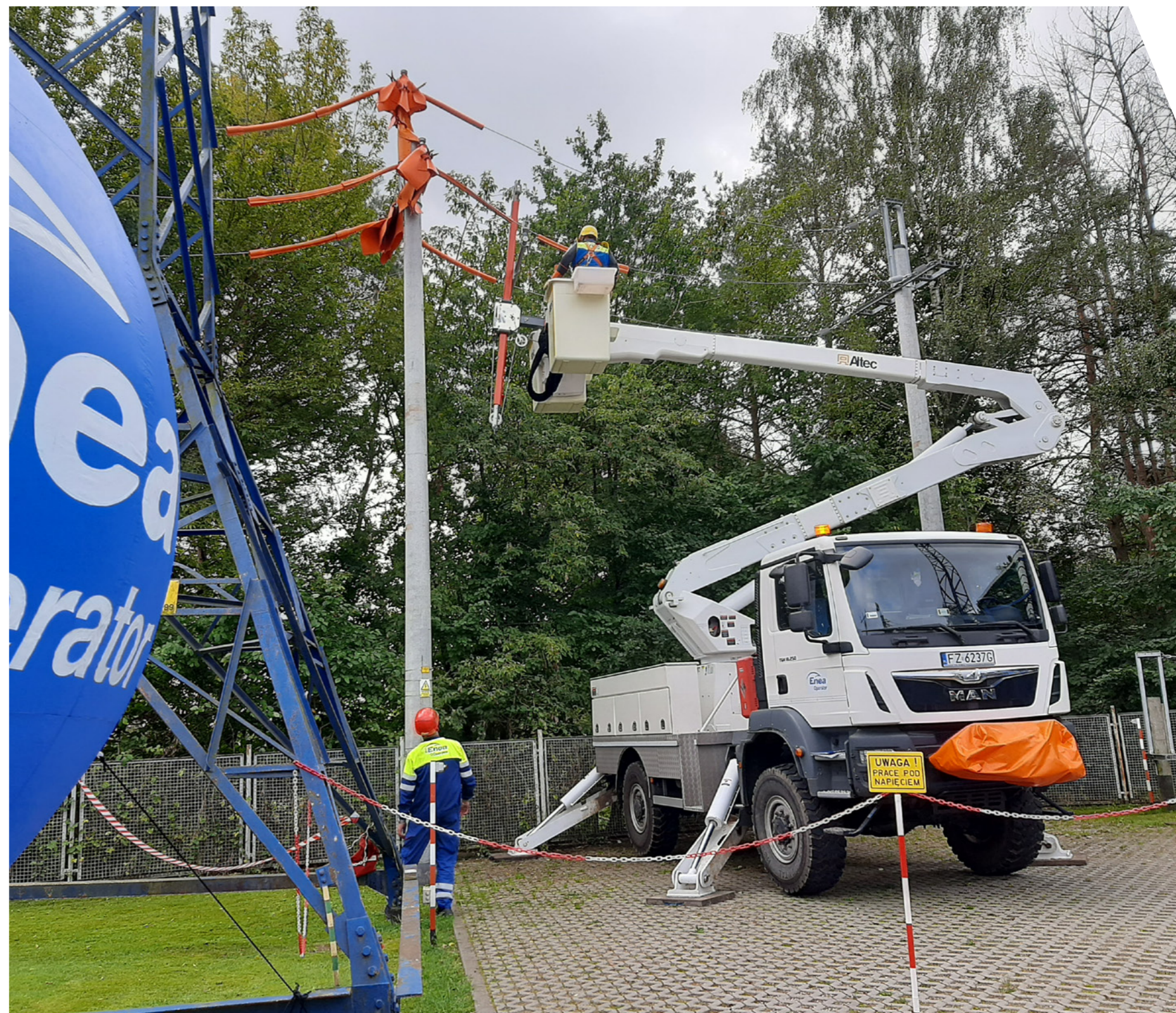
Enea Operator, Prace pod napięciem
